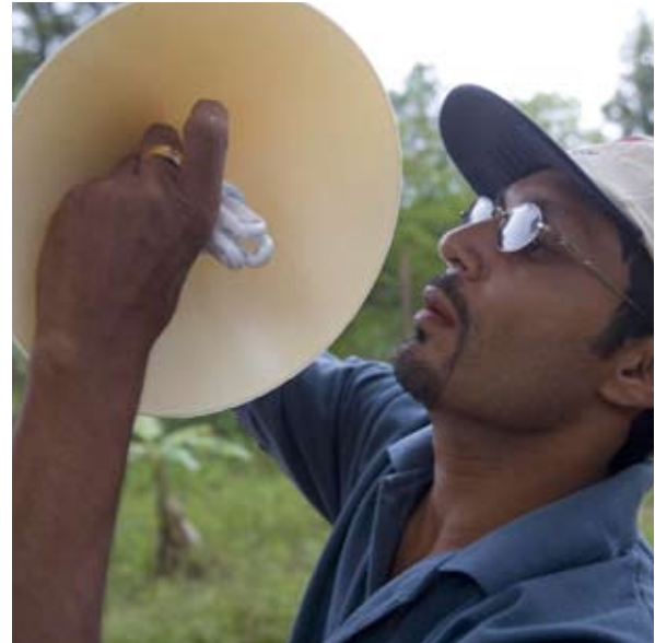
Elektriker Wasanthe vom Projektpartner ASPIRA in Sri Lanka, montiert eine Energiesparbirne in eine Straßenlampe.
